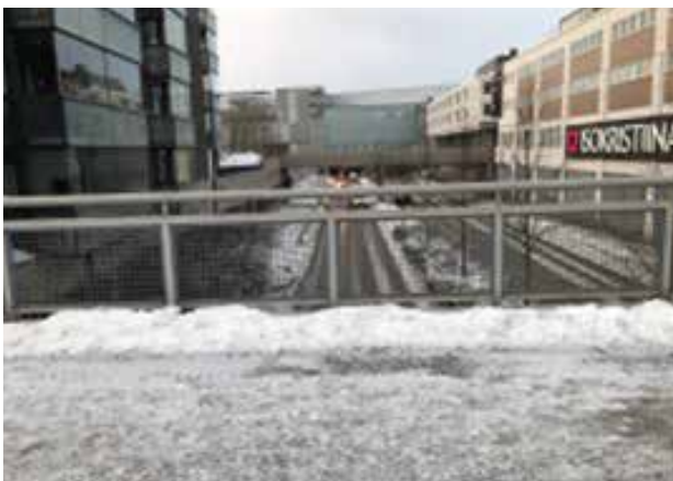
Kölhinpuiston silta Lappeenkatu Gallerian suuntaan
