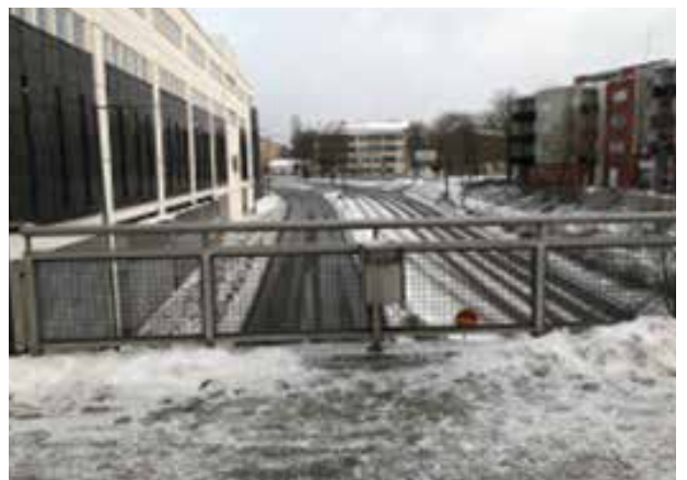
Kölhinpuiston silta Lappeenkatu vesitornin suuntaan
